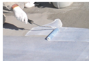
プライマー塗布
